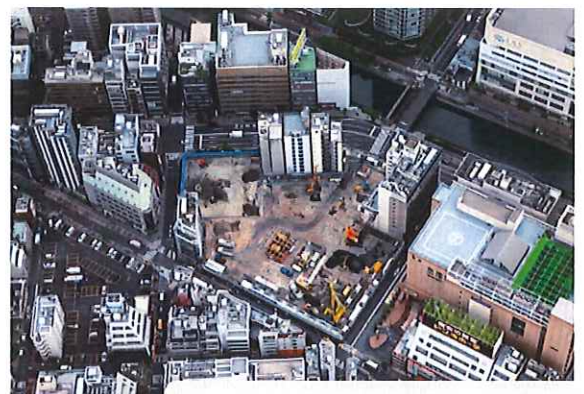
新ビル建設現場 2021年8月撮影
