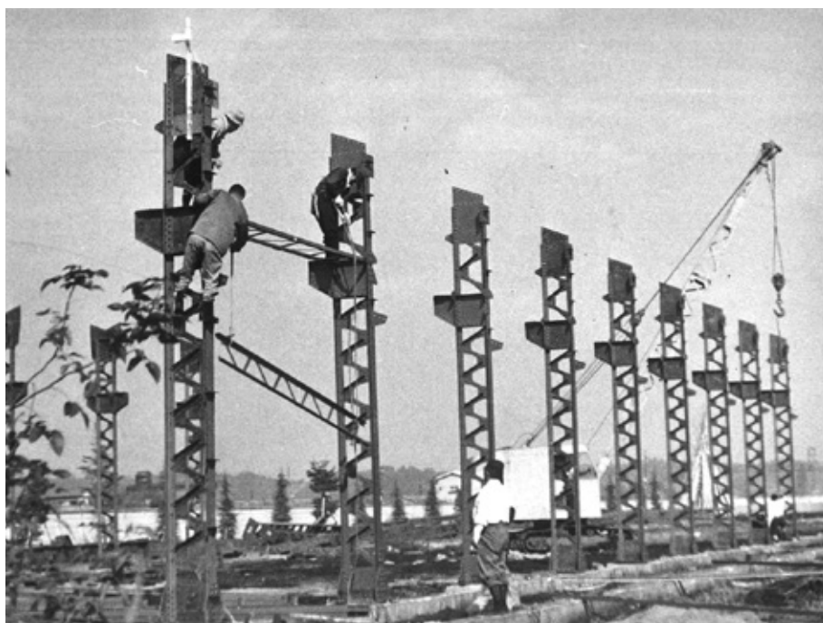
1959年(昭和34年) 相模原で工場建設工事が始まる
