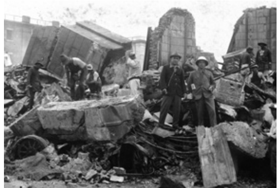
関東大震災で全壊したチャータード銀行 (横浜開港資料館所蔵)
