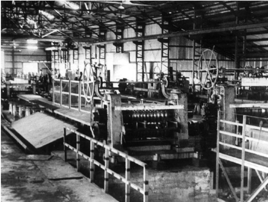
1955年(昭和30年) 当時横浜で使用していた圧延機 相模原に移転後もしばらく使用されていた
